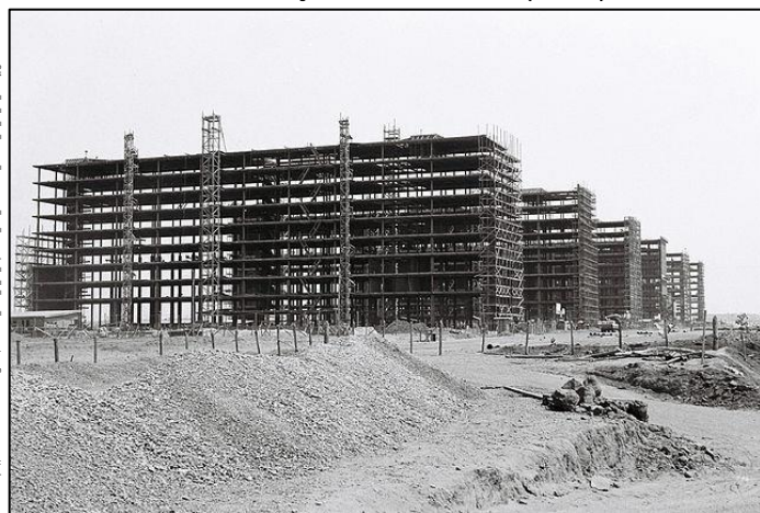
CONSTRUÇÃO DE BRASÍLIA (1960)
